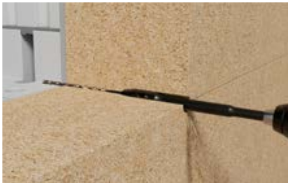
Mit der Bohrererlängerung EJOT drillX werden die Fasern des Dämmstoffes seitlich an den Rand des Bohrlochs gedrückt ohne dieses zu verstopfen.
